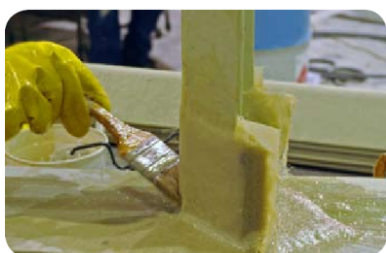
Рис.9. Устройство и оклеивание узлов сопряжения поверхностей
