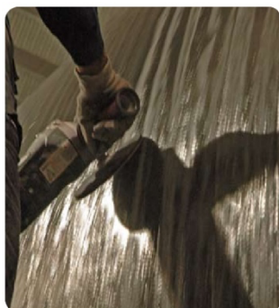
Рис. 11. Шлифовка поверхности УШМ
