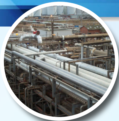
Антикоррозийная защита металлоконструкций
