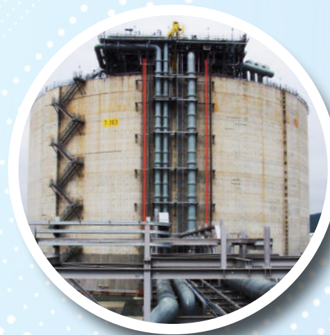
Защита теплоизоляции резервуаров
