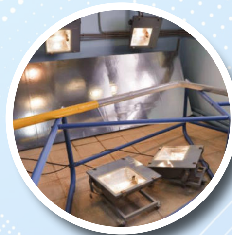
Защита газопровода от коррозии
