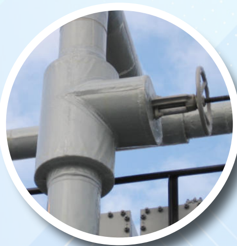
Защита изоляции трубопроводов
