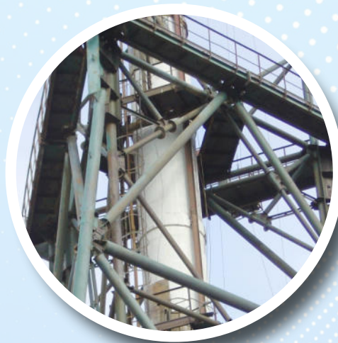
Восстановление бетонных конструкций
